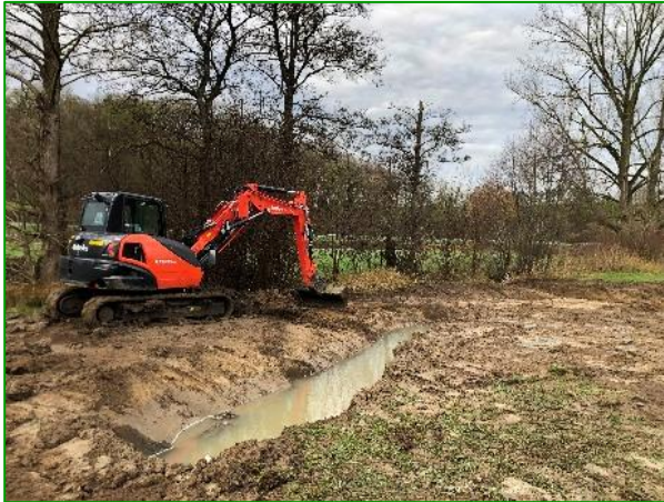
Baggerarbeiten für Bachlauf-Nebengerinne in den Kluswiesen
