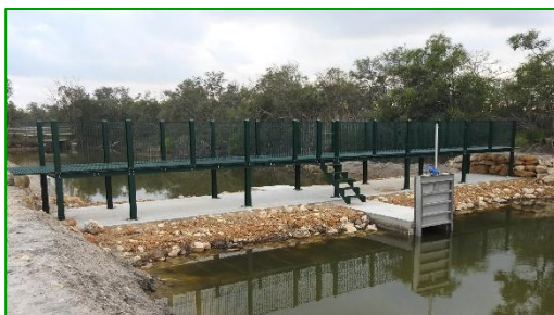
Pantano Longarini: neu errichteter Staudamm mit Übergang und Fischschleuse
